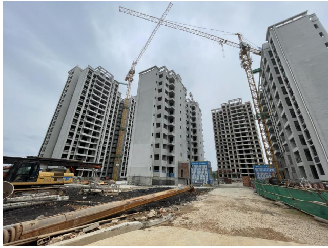
建构筑物施工
