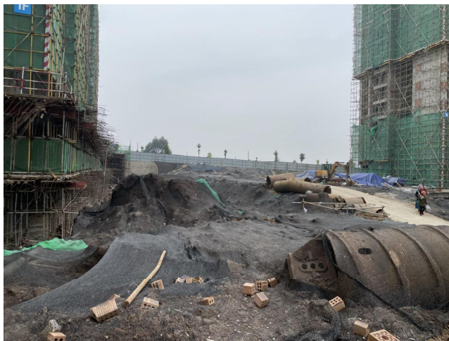
临时堆土场区
